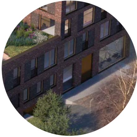
in- en uitrit parkeergarage
