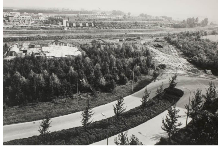
1977 De wijk Seghwaert in aanbouw met op de voorgrond de Van Aalstlaan. Op de voorgrond de oprit naar de Australieweg .
